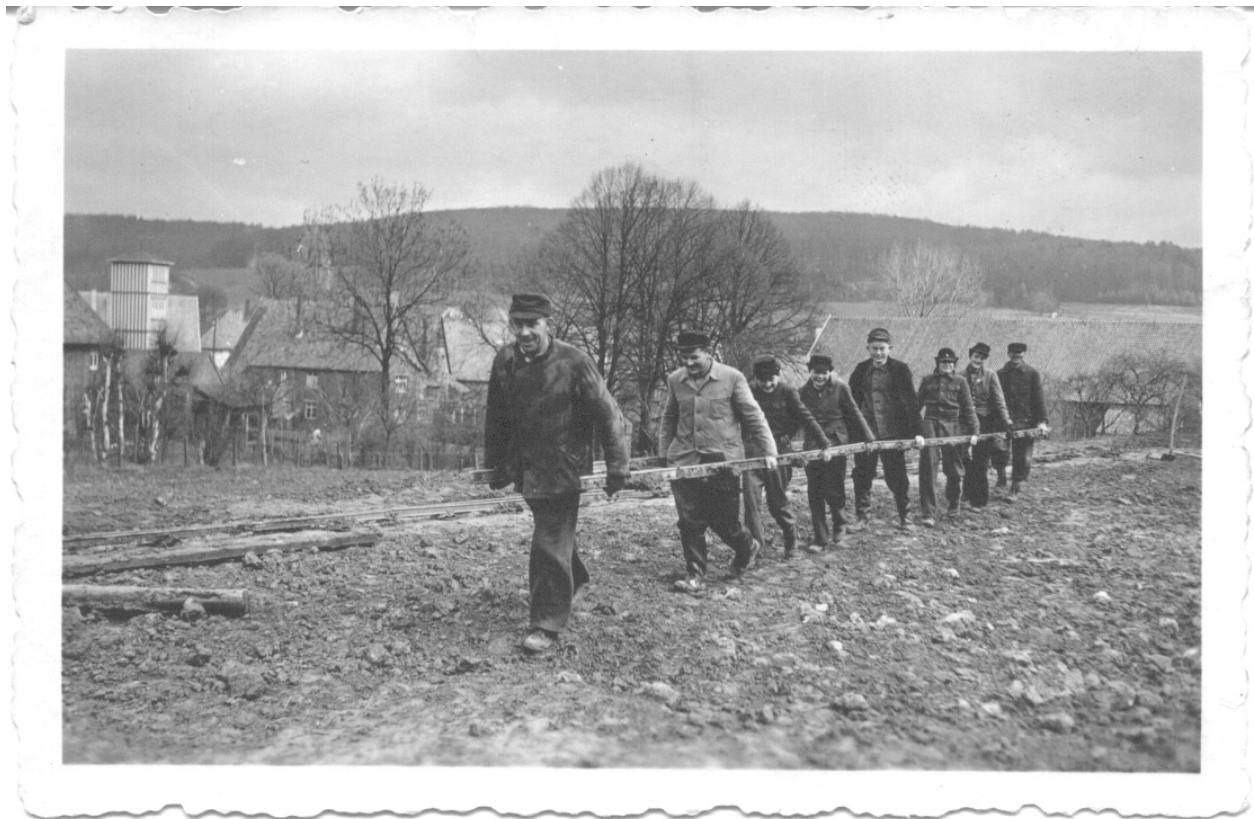
Umfassende Eigenleistungen ermöglichten den Bau des heutigen Sportplatzes
